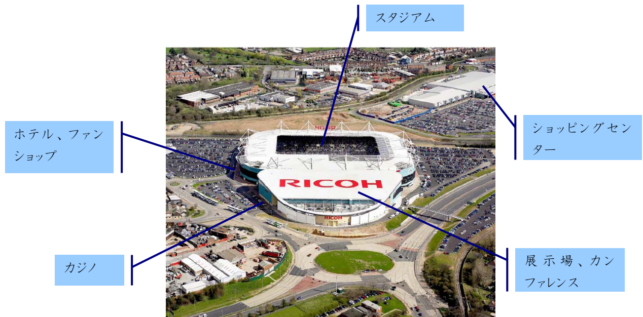
図 2：再開発後の現地の状況
