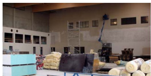
図 13：体育館(建設中)
