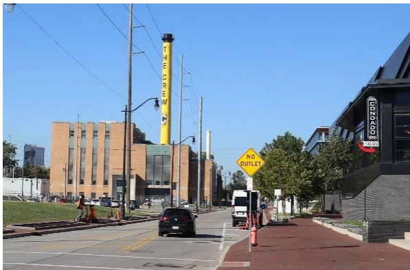
チームカラーが施された旧市営発電所の煙突
