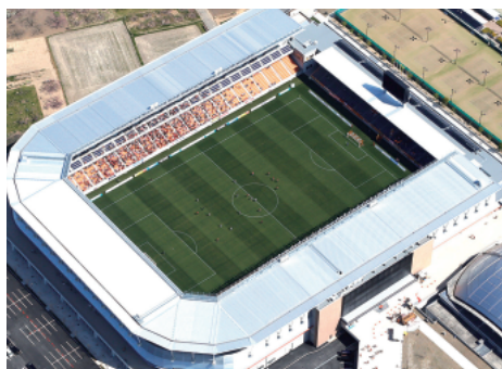
劇場のような南長野運動公園総合球技場。工期はわずか14カ月。U字型のスタンドは2層。アウェイ側スタンドのみ1層でピッチへの日照を確保
