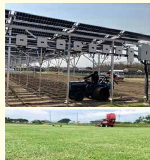
ガイナレ鳥取が取り組む「しばふる太陽光発電所」（太陽光発電と芝生生産のソーラーシェアリング）。
